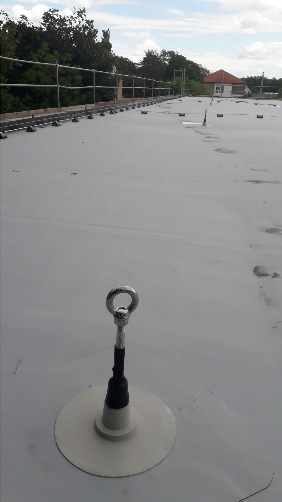
Fertiggestellte Dachabdichtung
